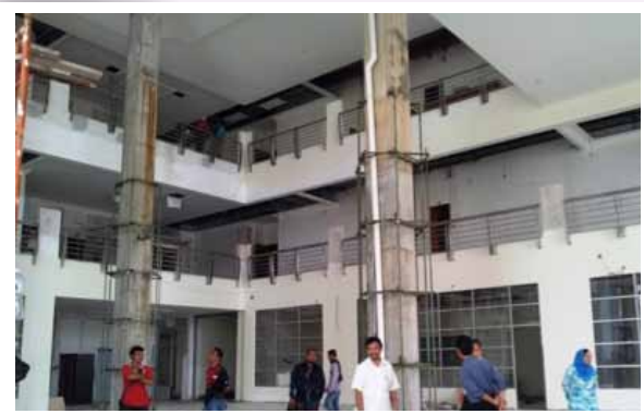
Lawatan ke Tapak Bangunan Tambahan Mahkamah Baru Klang pada 22 Julai 2013
